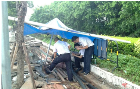
设备动力部冒雨抢修电缆
